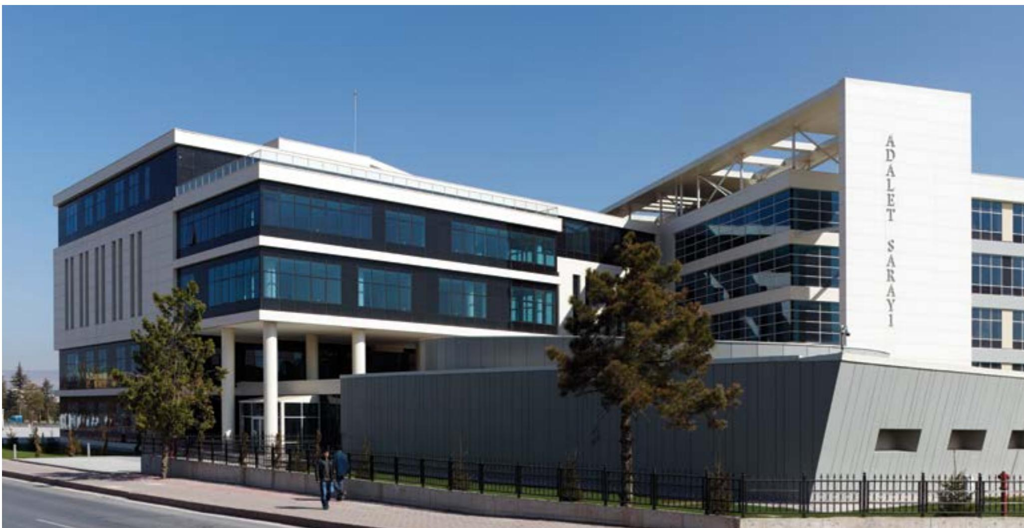
Kayseri Adliye Sarayı / Kayseri — 3mm Mat Fit Beyaz - 3mm Mat Fit Çimento Gri - 3mm Mat Fit Fildiği / Gizli Klipsli Sistem
